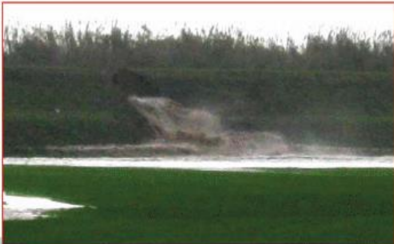
08.45 CET La venuta ha scavato una voragine nell'argine
