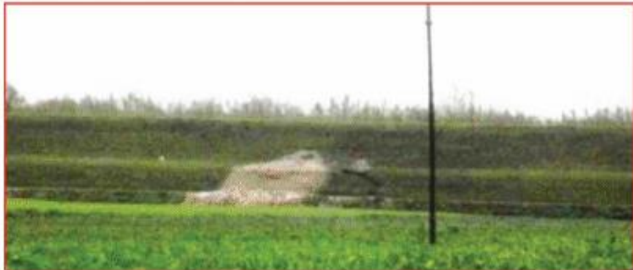
08.15 CET Venuta arginale laterale nell'argine
